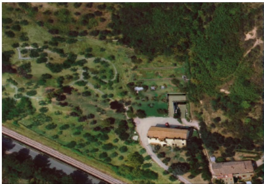
3. VEDUTA AEREA, DOPO LA COSTRUZIONE DEL VOLUME IPOGEO, CON IL RIPORTO DEL TERRENO VEGETALE SULLA COPERTURA DEL MAGAZZINO E LA RICOSTRUZIONE DELL'AMBIENTE NATURALE ORIGINARIO. PRESSO IL CASALE, UTILIZZATO PER ALLESTIMENTI ESPOSITIVI E DIDATTICI, SONO VISIBILI GLI INGRESSI PEDONALI D'ACCESSO AI PIANI SUPERIORI E LE RAMPE PER IL TRASPORTO DEI REPERTI ALLE ZONE DI PRESTOCCAGGIO (foto R.D.R.)
