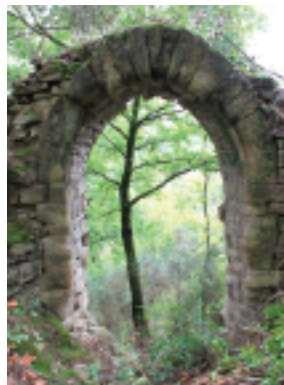
7. CASTELLACCIO DI MONTELABATE: PORTA DI INGRESSO A SESTO RIALZATO. SETTEMBRE 2010 (foto dell'A.)
