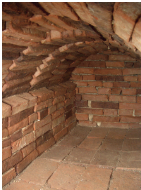
3. COLLE DELL'ANNUNZIATA. LA STRUTTURA DOPO LO SCAVO (foto SBAU)
