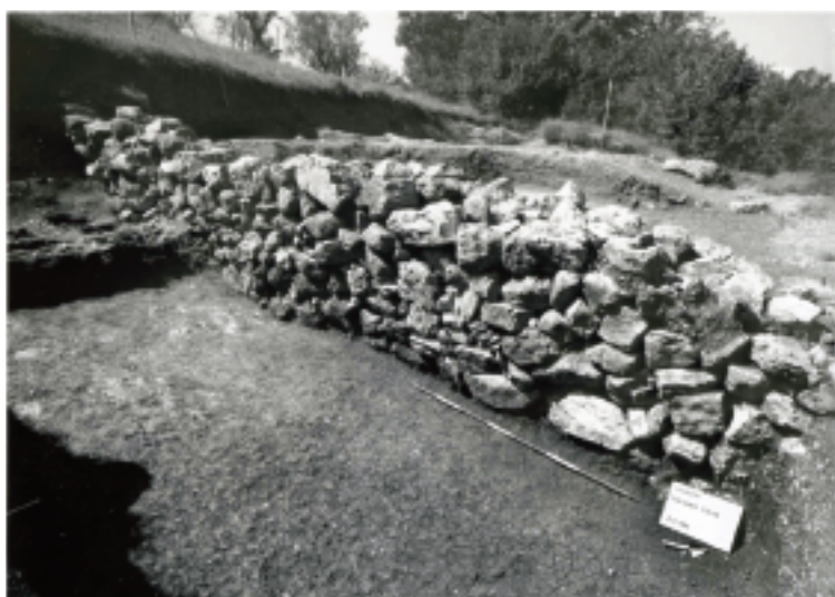
6. ANCARANO DI NORCIA. MURO EST DEL SACELLO
