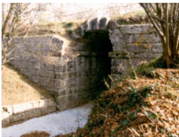
10. MASSA MARTANA. PONTE FONNAIA SULLA VIA FLAMINIA
