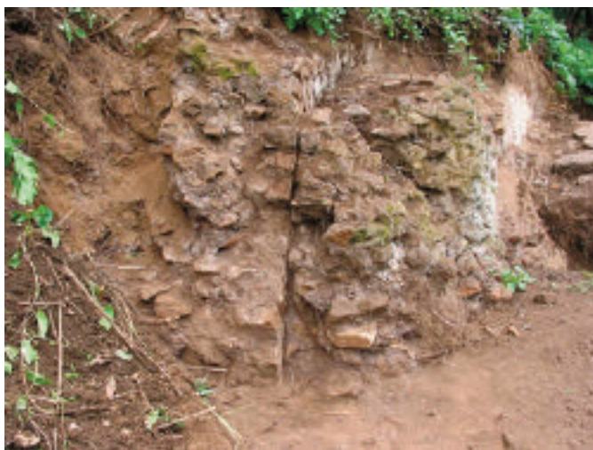
7. ROMA. VIA MARGUTTA 54. IL MURO US 303 (A SIN.) CUI SI ADDOSSA A RINFORZO IL MURO US 302 (AF SSCOL)
