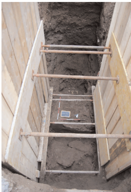
15. ROMA. S. CROCE IN GERUSALEMME. IL TRATTO DI MURATURA VISTO DALL'ALTO (foto AFSSCol)
