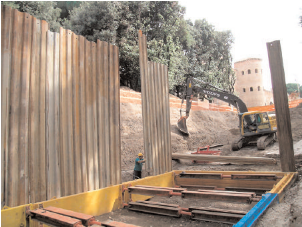
3. VIA SANNIO. GIARDINO PUBBLICO. AREA DI SCAVO. PALANCOLATO AUTO-AFFONDANTE (foto SS-Col)
