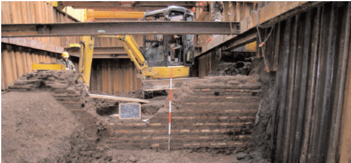
30. VIA SANNIO. GIARDINO PUBBLICO. PERIODO 6. CANALE DI DRENAGGIO (foto SS-Col)
