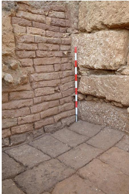
Fig. 7 - Detalle del relleno de adobes de la muralla de Tarraco (según AQUILUÉ ET AL. 1991, 290, fig. 14).
