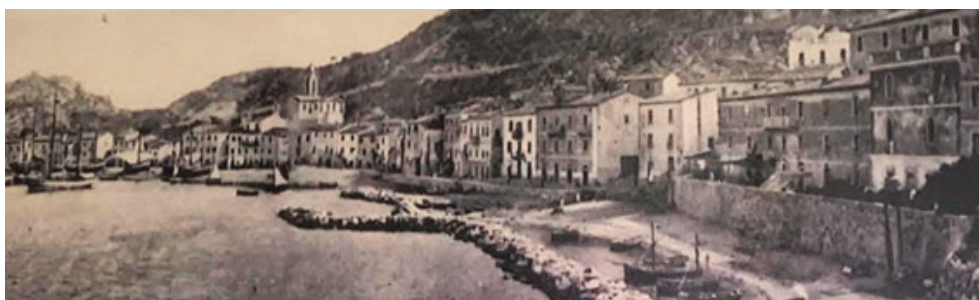
8. ISOLA DEL GIGLIO, GIGLIO PORTO: FOTOGRAFIA DEI PRIMI DEL NOVECENTO (gentile concessione di R. Pini)
