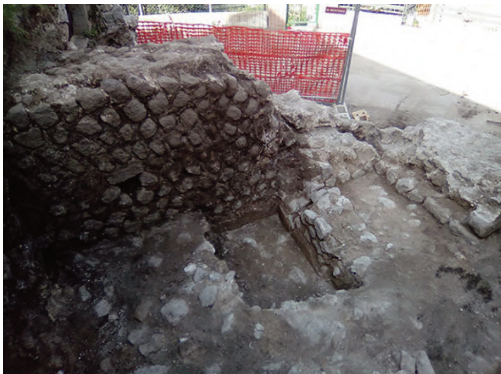
5. ISOLA DEL GIGLIO, GIGLIO PORTO: PARTICOLARI DELLE STRUTTURE MURARIE INDAGATE (foto M. Colombini)
