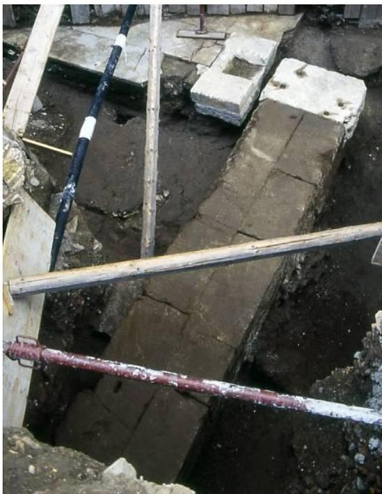
Fig. 5 . In primo piano il muro in blocchi di tufo dell'Aniene della fronte della cella con il plinto in travertino per l'alloggio dello stipite e in corrispondenza il blocco con l'incasso per il cardine del portale. Sul fondo le lastre di marmo bianco della pavimentazione del pronao (foto: Autore).
