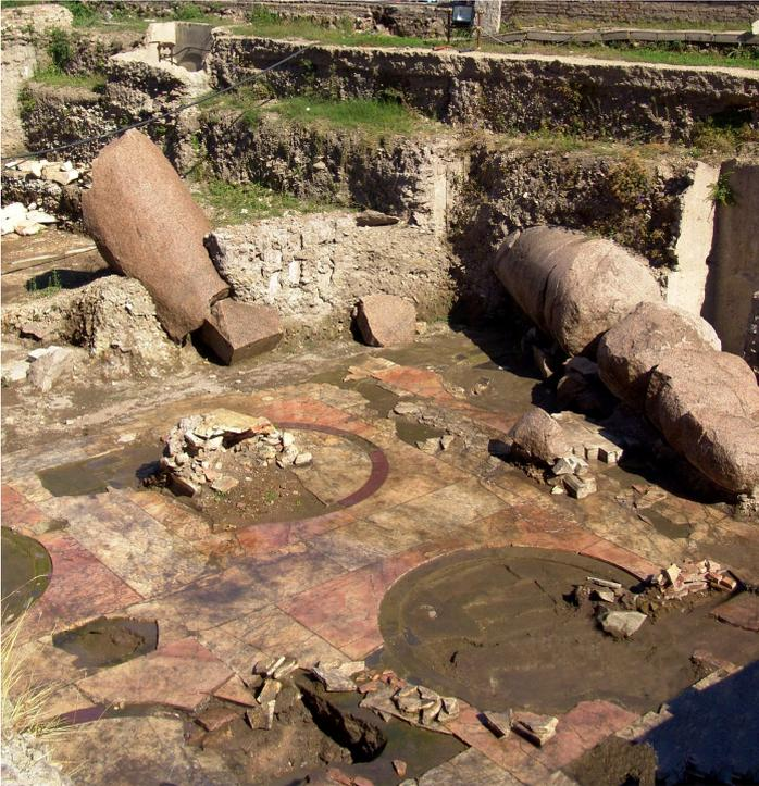
Fig. 3 . Aula di culto del *Templum Pacis* con parti delle colonne del pronao in stato di crollo (foto S. Fogagnolo).
