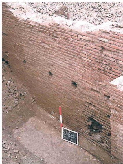
Fig. 3. Resti di strutture murarie in opera laterizia e pavimenti in opus spicatum.
