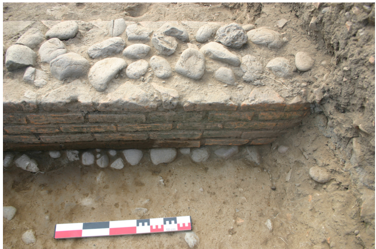
Fig. 5 - Dettaglio del muro in opera laterizia e dello spiccato delle fondazioni.
