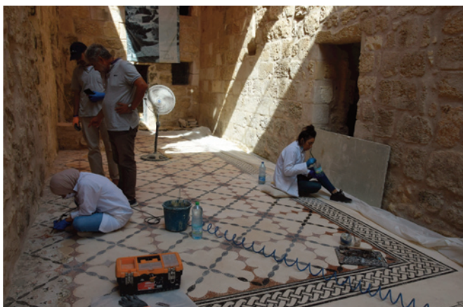
7. BETANIA. LAVORI DI PULIZIA E RESTAURO INTEGRATIVO DI UNA DELLE PAVIMENTAZIONI A MOSAICO DELLA CHIESA SORTA NEI PRESSI DELLA TOMBA DI LAZZARO (foto C. Benelli)
