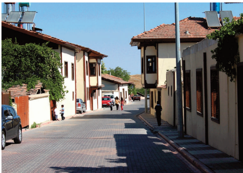
27. STRADA NEL VILLAGGIO DI ORDUZU CON CASE IN MATTONI CRUDI RESTAURATE
