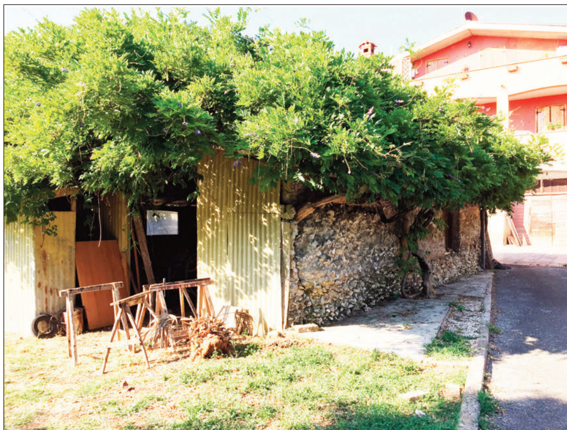
8. PALESTRINA, STRUTTURA MURARIA IN CONGLOMERATO CEMENTIZIO ALL'INTERNO DI UNA ABITAZIONE PRIVATA (foto Autore)
