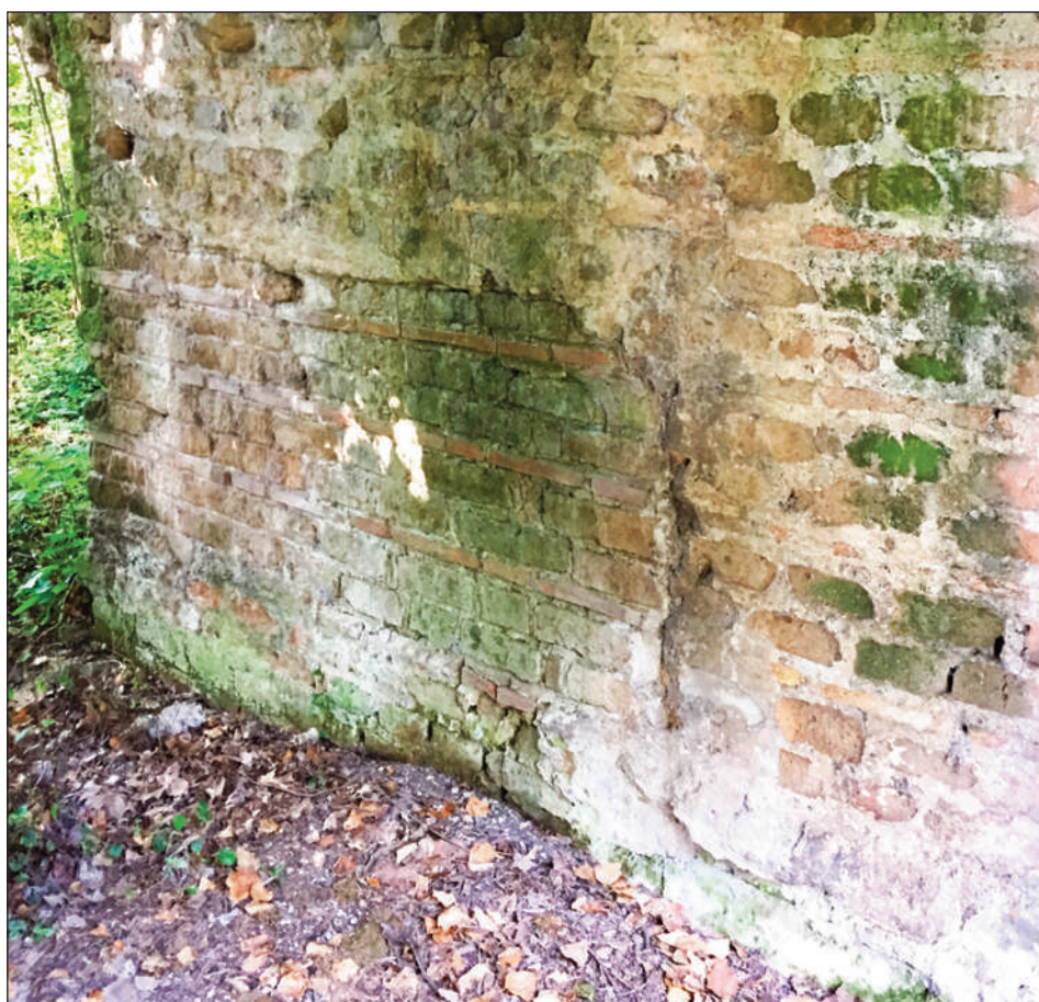
15. IL CD. "NINFEO DEL SOLE", PARTICOLARE DELLA TECNICA EDILIZIA IN OPERA LISTATA (foto Autore)
