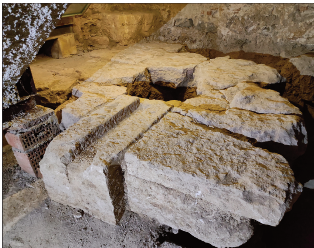
11. SOMMITÀ DEL POZZO DI DRENAGGIO POSTO NELL'ANGOLO INTERNO TRA LE MURATURE DEL TERRAZZAMENTO; SI OSSERVA UN CANALE LAPIDEO DI SCOLO DELLE ACQUE VERSO LA PARETE NORD-OVEST (foto Autori)
