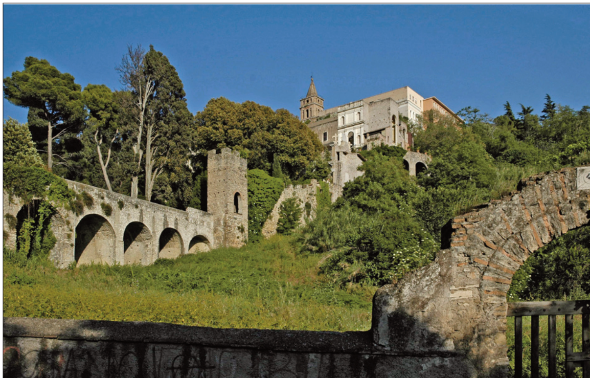
7. VILLA D'ESTE. SOSTRUZIONI E TORRE BARBAROSSA (foto Istituto autonomo Villa Adriana e Villa d'Este-VILLÆ, Tivoli)
