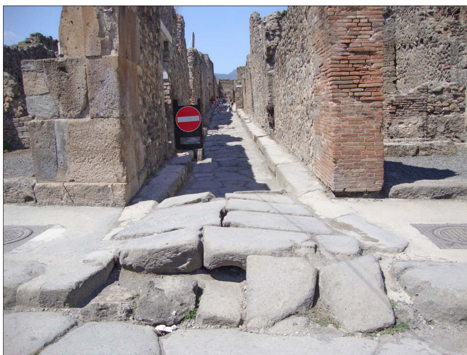
Fig. 5. Soluzioni tecniche per la viabilità: a. Terracina (LT), area forense. Si nota la differenza di pavimentazione tra la piazza in lastre e la via Appia in basoli (foto Autore); b. Pompei (NA), interferenza tra viabilità ed esigenze dello smaltimento idrico; con i blocchi disposti a schiena d'asino si assicura il percorso pedonale e carrabile (foto Autore).
