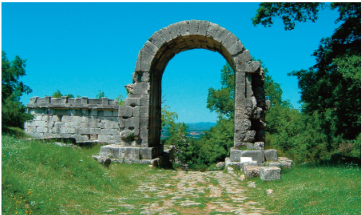
7. CARSULAE. C.D. ARCO DI SAN DAMIANO: MONUMENTALIZZAZIONE DELL'INGRESSO SETTENTRIONALE DELLA VIA FLAMINIA IN CITTÀ.
