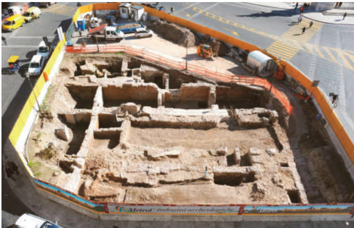
3. ROMA. PIAZZA DELLA MADONNA DI LORETO. VEDUTA DELL'OSPEDALE IN CORSO DI SCAVO (foto Archivio SSBAR)
