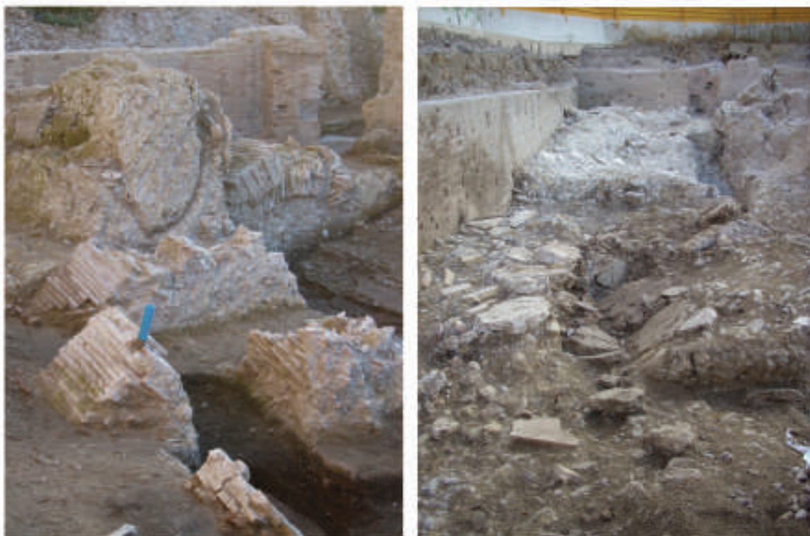
14. ROMA. PIAZZA DELLA MADONNA DI LORETO. FOTO DEL CROLLO DELLE VOLTE DELL'ATHENAEUM AVVENUTO IN SEGUITO AL TERREMOTO DELL'847 (foto Archivio SSBAR)
