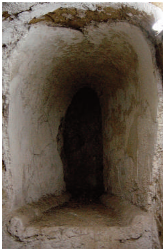
7. ROMA. PINCIO. CASINA VALADIER. CISTERNA A CUNICOLI: RESTRINGIMENTO DEL CUNICOLO IN CORRISPONDENZA DEL POZZO VERTICALE
