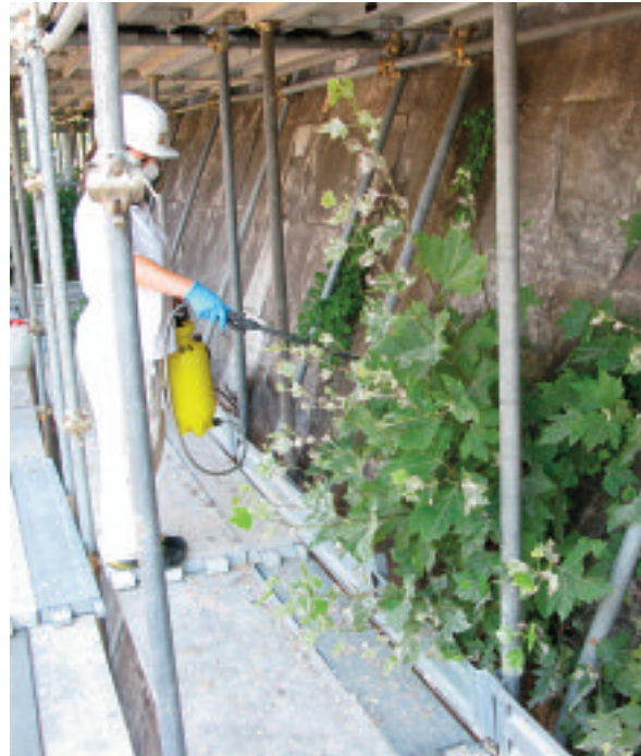
13. ROMA. PIRAMIDE DI CAIO CESTIO. TRATTAMENTO DELLA VEGETAZIONE SUPERIORE
