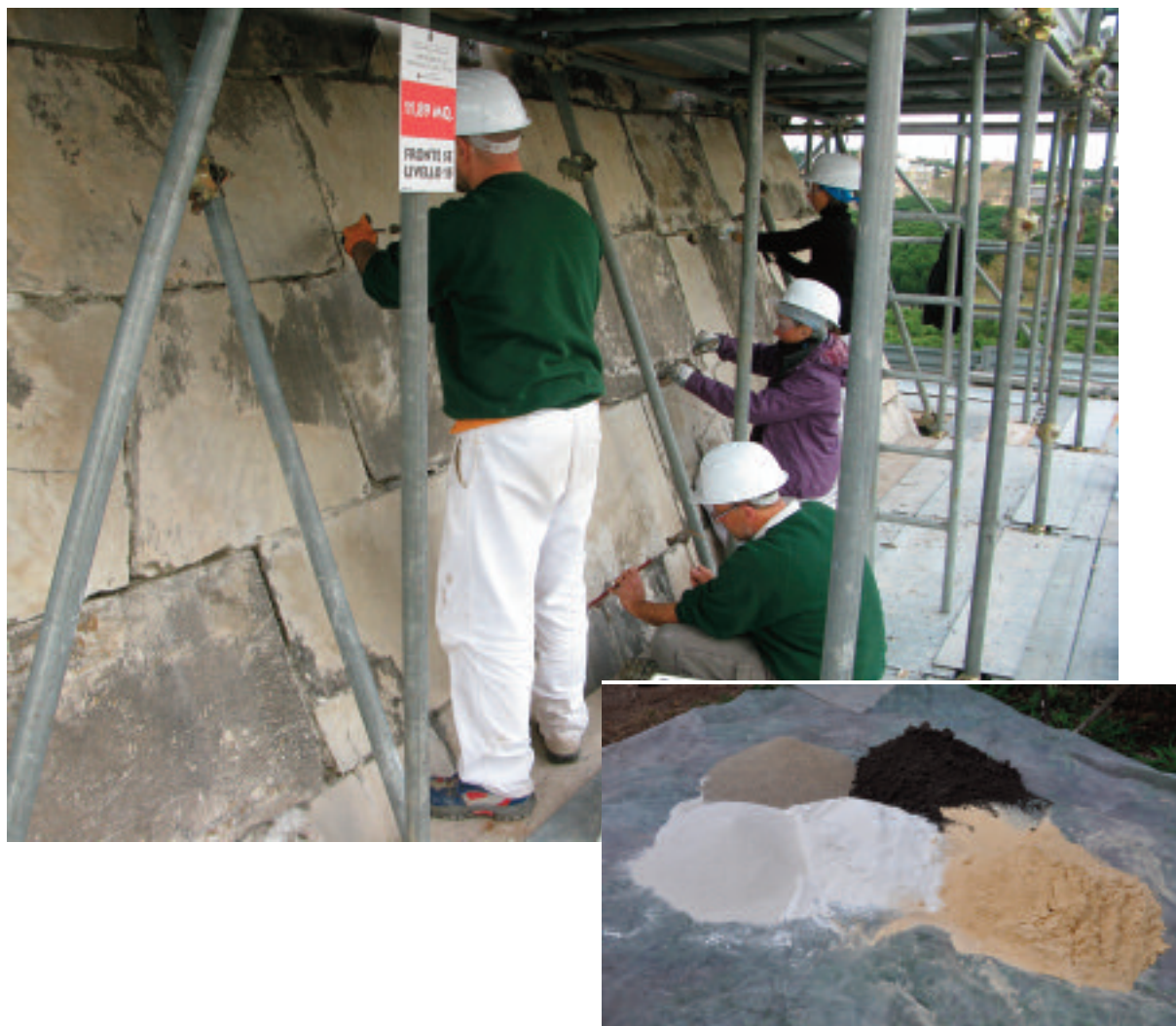
15-16. ROMA. PIRAMIDE DI CAIO CESTIO. RIMOZIONE DELLE STUCATURE INCONGRUE (a sin.) E PARTICOLARE DELLE CARICHE (a dx.) UTILIZZATE PER IL RIPRISTINO DELLE STILATURE E DELLE RICONFIGURAZIONI
