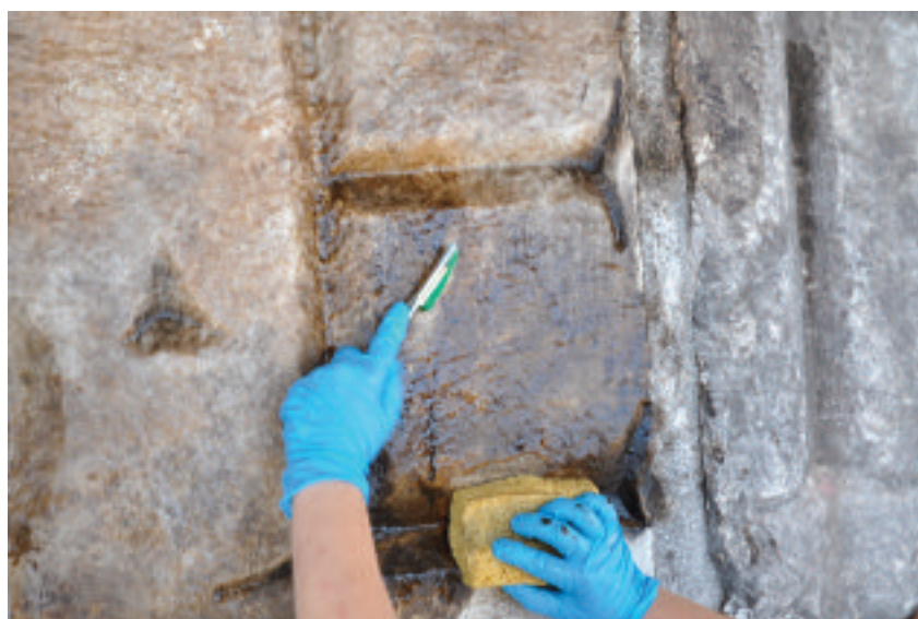
11. ROMA. PIRAMIDE DI CAIO CESTIO. RIMOZIONE DEI RESIDUI DEL TRATTAMENTO BIOCIDIA
