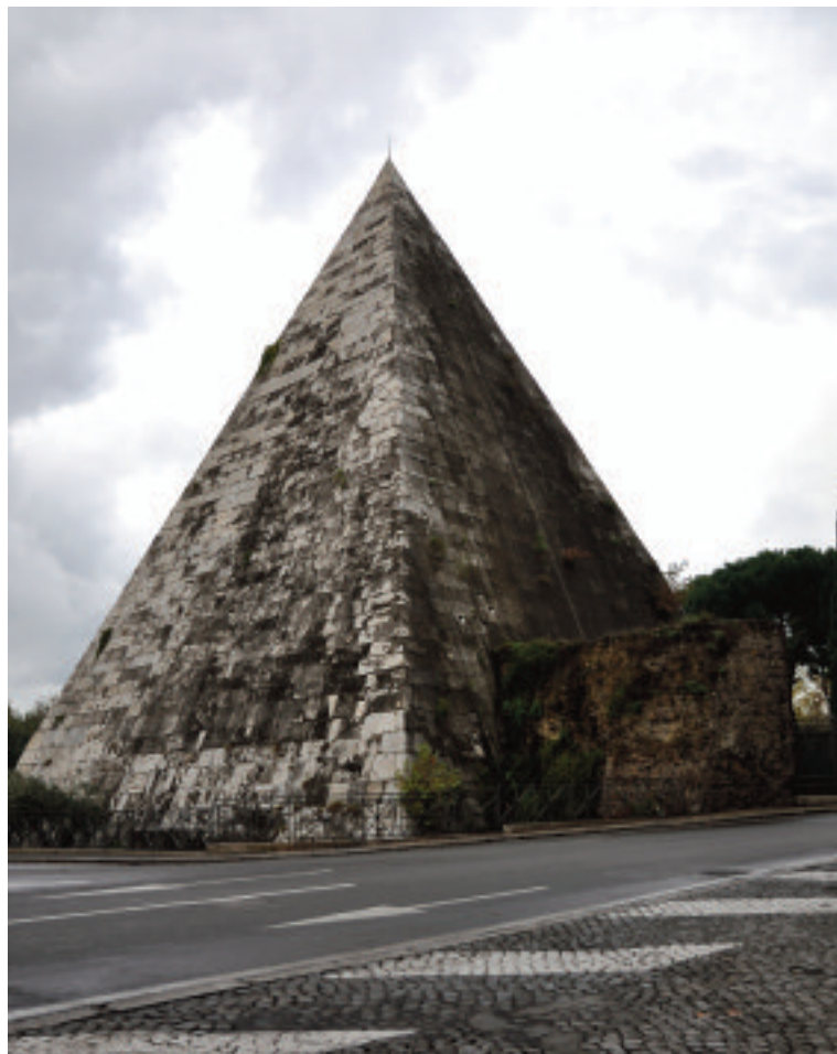
2. ROMA. PIRAMIDE DI CAIO CESTIO PRIMA DEL RESTAURO. ANGOLO EST
