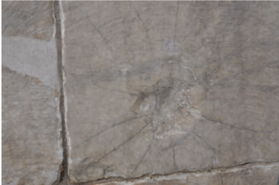
7. ROMA. PIRAMIDE DI CAIO CESTIO. SUPERFICIE ESTERNA: COLPO DI ARTIGLIERIA. DETTAGLIO
