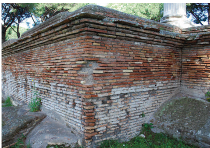
6. SCAVI DI OSTIA. TEMPIO DI CERERE, 1912. RIPRESA MIMETICA DELLA CORTINA DEL PODIO E DELLA CORNICE SOMMITALE
