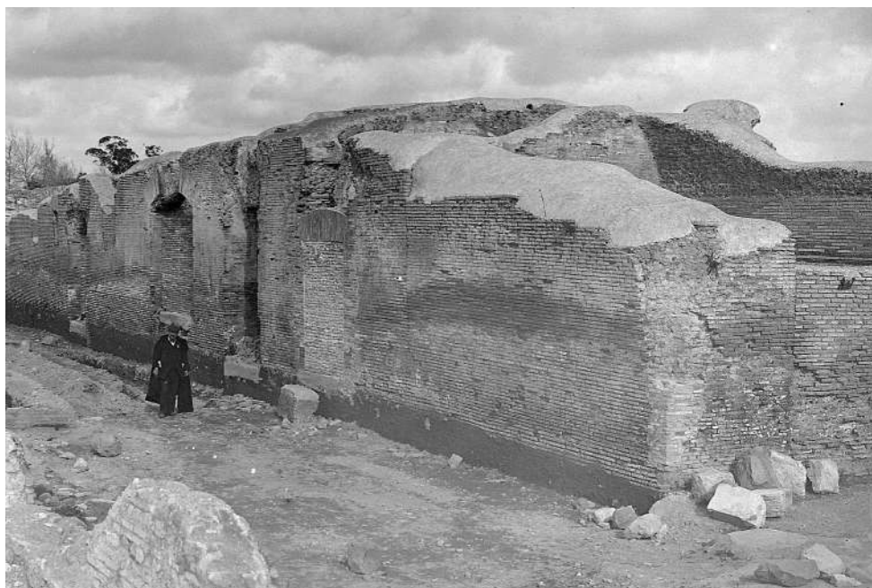
1. SCAVI DI OSTIA. DANTE VAGLIERI ALL'ESTERNO DELLA CASERMA DEI VIGILI. VISIBILI LE COPERTURE IN COCCIOPESTO ESEGUITE PRIMA DEL SUO ARRIVO (neg. SSBAR-Ostia, AF, B 1968)
