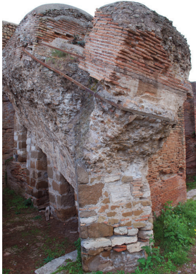
9. SCAVI DI OSTIA. TEATRO, LATO OVEST, 1913. CONSOLIDAMENTO IN SITU DEL CROLLO DELLA COPERTURA MASSIVA
