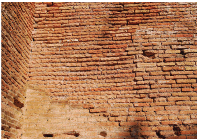
5. SCAVI DI OSTIA. TERME DI NETTUNO, 1910. INTEGRAZIONE RESA RICONOSCIBILE DALLO SCALPELLAMENTO DEI MATTONI E DAL SOTTOSQUADRO
