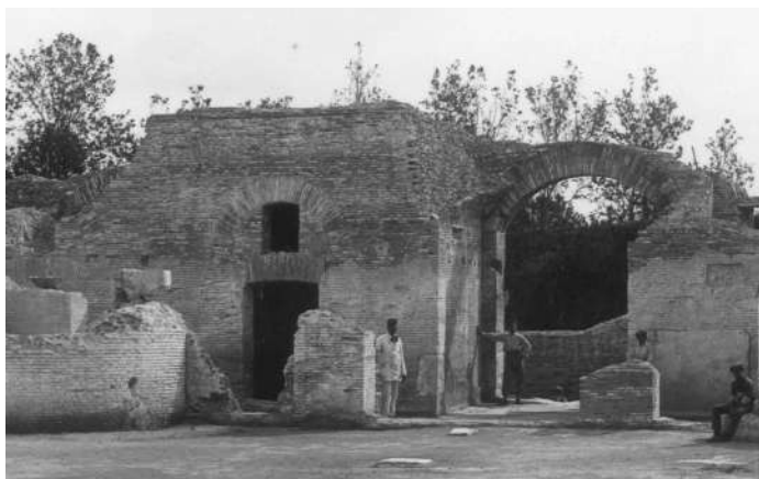
8. SCAVI DI OSTIA. CASERMA DEI VIGILI. LATO EST, 1912. A CONCLUSIONE DEI LAVORI, LE CRESTE DEGLI ELEVATI RISULTANO SOTTOPOSTE A FERMATURE CON MALTA O INTEGRATE A IMITAZIONE DEI NUCLEI MURARI (neg. SSBAR-Ostia, AF, B 2029)
