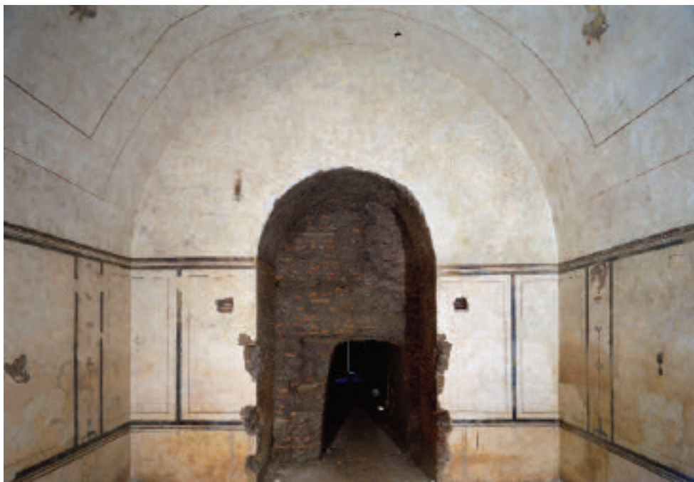
4. ROMA. PIRAMIDE DI CAIO CESTIO. INTERNO. PARETE N-O DOPO IL RESTAURO
