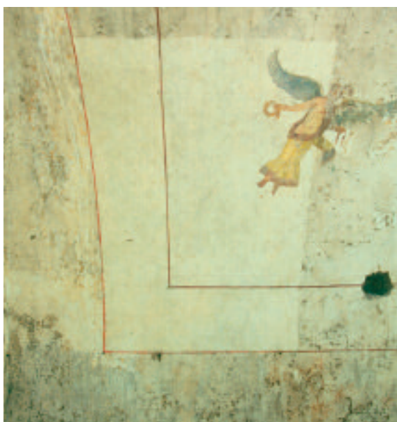
16. ROMA. PIRAMIDE DI CAIO CESTIO. INTERNO. TASSELLO DI PULITURA PER LA RIMOZIONE DEI DEPOSITI CARBONATATI
