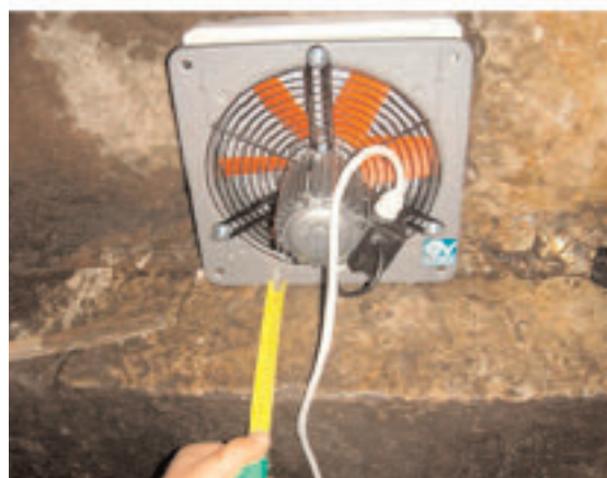
29. ROMA. PIRAMIDE DI CAIO CESTIO. INTERNO. IN ALTO APERTURA IN CIMA AL CUNICOLO MEDIEVALE. IN BASSO INSERIMENTO DELLA VENTOLA NELL'APERTURA
