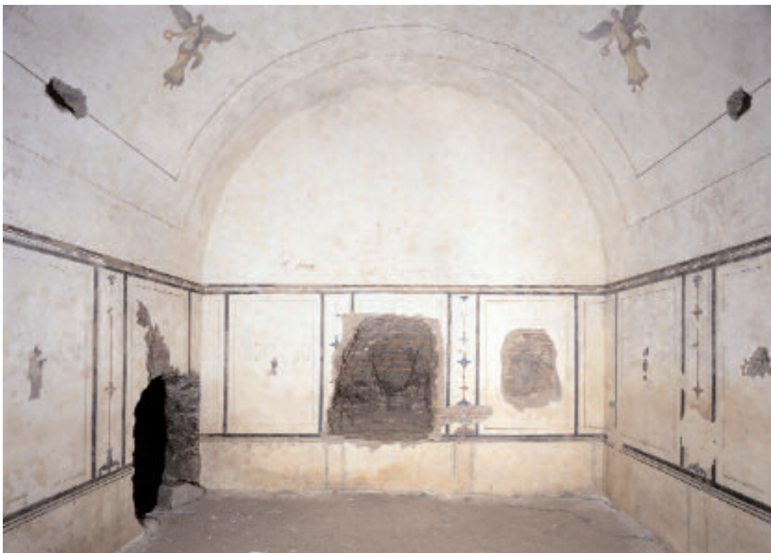
3. ROMA. PIRAMIDE DI CAIO CESTIO. INTERNO. PARETE S-E DOPO IL RESTAURO
