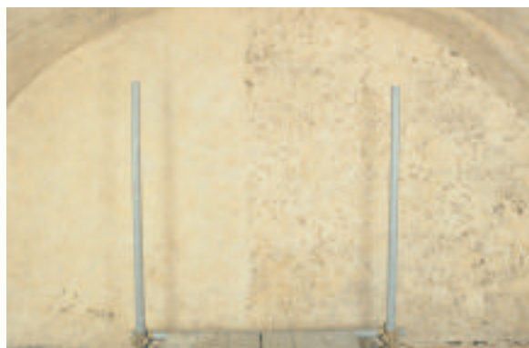
19. ROMA. PIRAMIDE DI CAIO CESTIO. INTERNO. PARTICOLARE DELLA VOLTA DURANTE LA FASE DI STUCCATURA CHE HA RESTITUITO LA CORRETTA LETTURA
