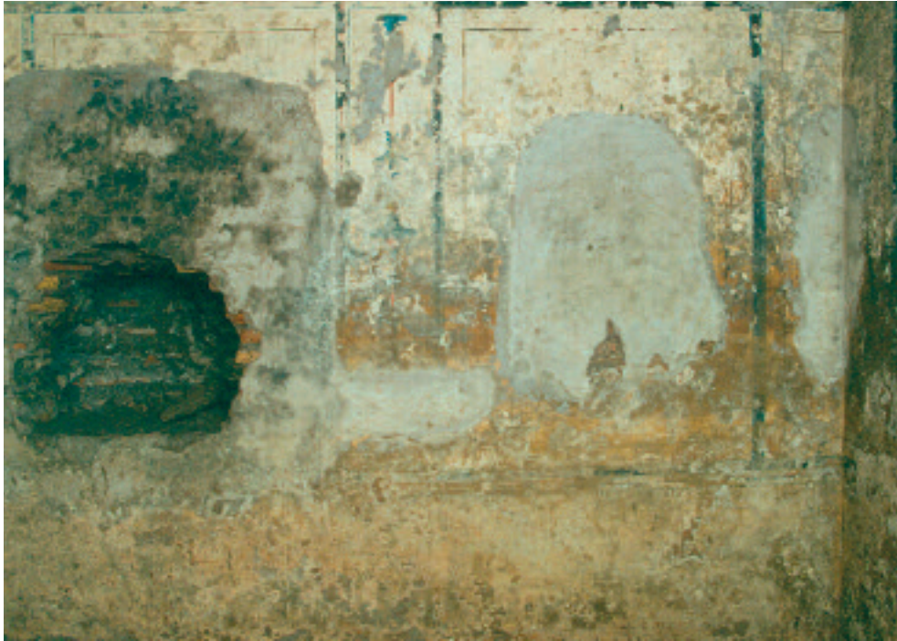
11. ROMA. PIRAMIDE DI CAIO CESTIO. INTERNO. PARETE S-E PRIMA DEL RESTAURO. SONO PRESENTI DUE IMPORTANTI TAMPONATURE DI ANTICHE VIOLAZIONI
