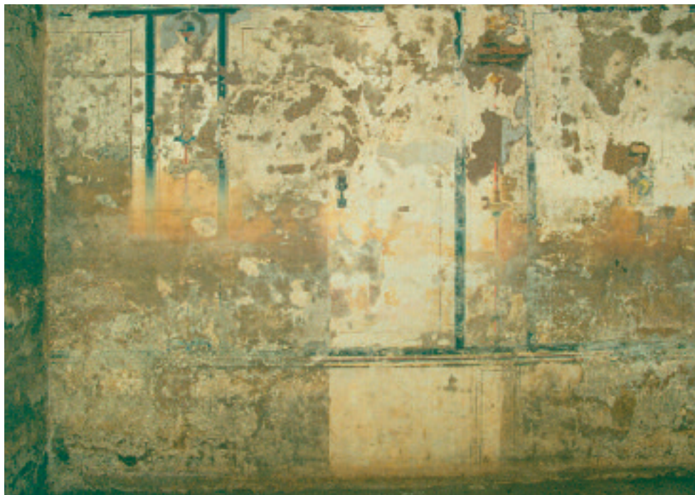
13. ROMA. PIRAMIDE DI CAIO CESTIO. INTERNO. PARETE N-E PRIMA DEL RESTAURO. SI NOTA LA PRESENZA DI UNO DEI SAGGI DI PULITURA REALIZZATO DALLA SOPRINTENDENZA NEGLI ANNI '80
