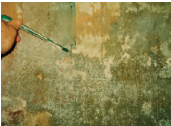
14. ROMA. PIRAMIDE DI CAIO CESTIO. ZONA DEL MICROPRELIEVO REALIZZATO PRELIMINARMENTE ALL'INTERVENTO DI RESTAURO PER L'IDENTIFICAZIONE DEI MATERIALI E DEI DEGRADI (foto ARTELAB s.r.l.)
