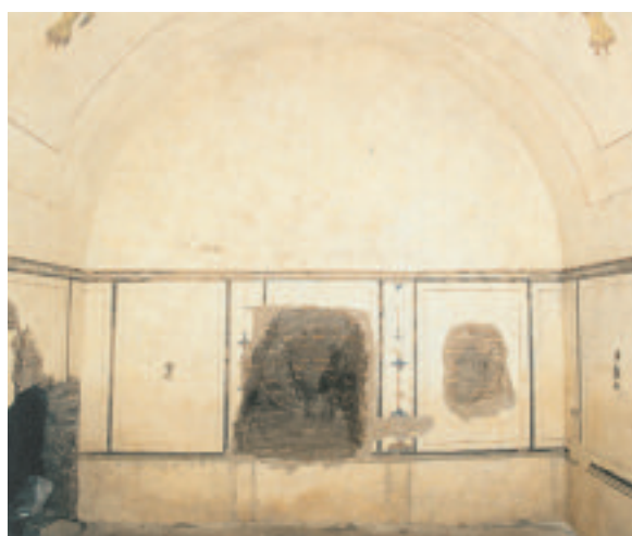
21. ROMA. PIRAMIDE DI CAIO CESTIO. INTERNO DOPO IL RESTAURO. PARETE S-E. IL CUNICOLO MEDIEVALE E LE LACUNE NON SONO STATE RISARCITE
