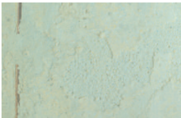
18. ROMA. PIRAMIDE DI CAIO CESTIO. INTERNO. PARTICOLARE DEI DIVERSI TIPI DI MALTA DI RESTAURO SIMILI AL LIVELLO DI INTONACO ORIGINALE CIRCOSTANTE
