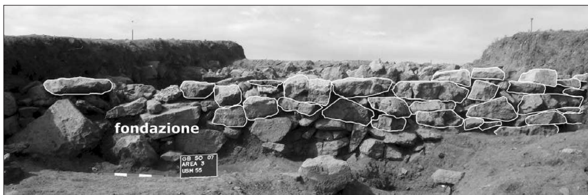
10. SAGGIO III. MURO FRONTALE, FACCIA ESTERNA (da FABBRI, MUSCO 2016)
